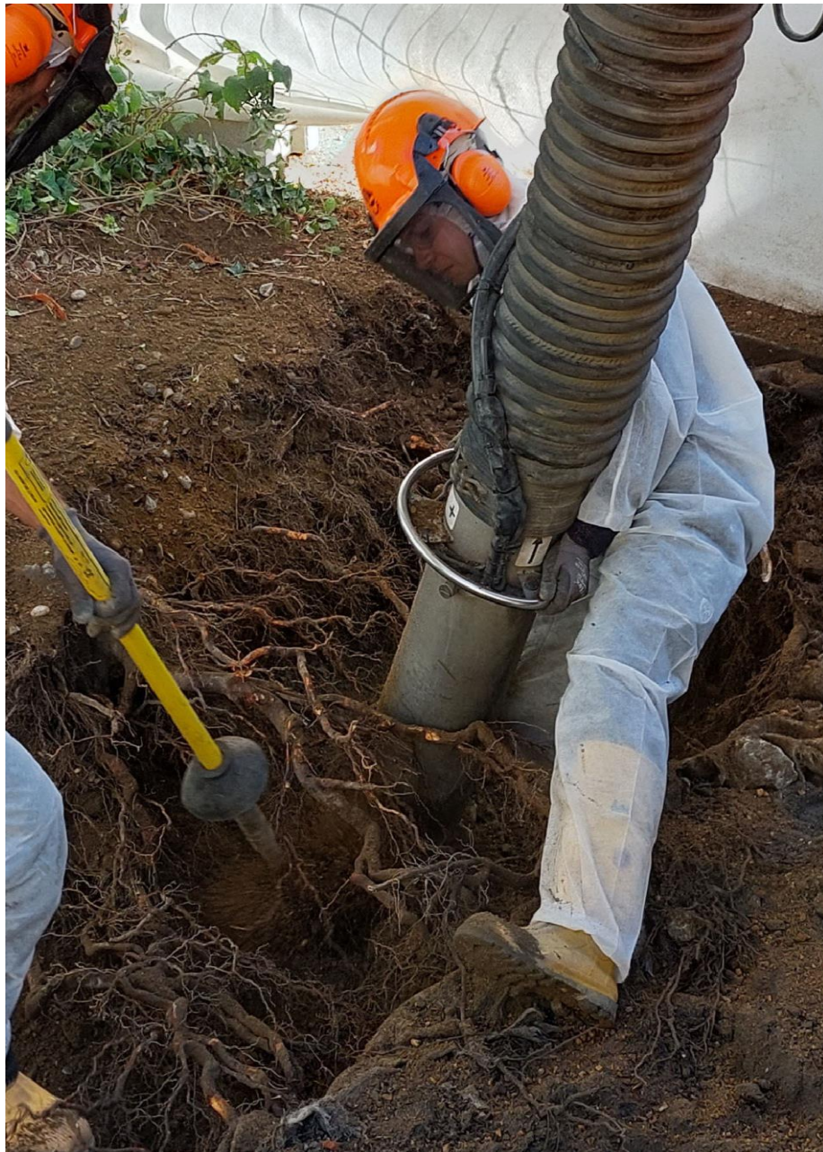
Detail Auflockerungsarbeiten im Wurzelbereich
