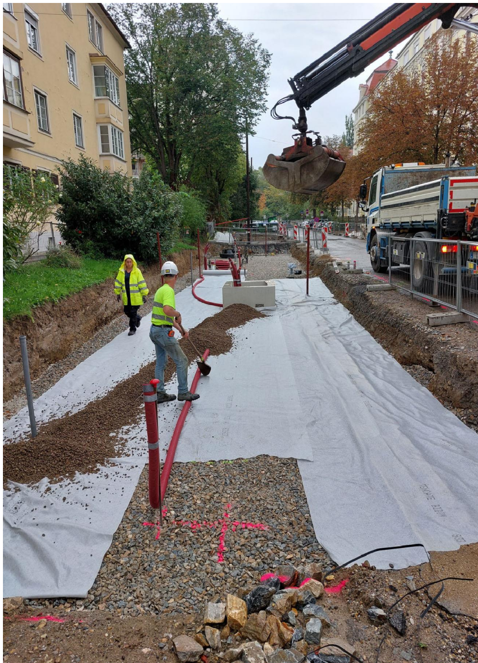
Geotex Vlies Abdeckung Verlegung der Einlaufrohre und Verteilerleitungen
