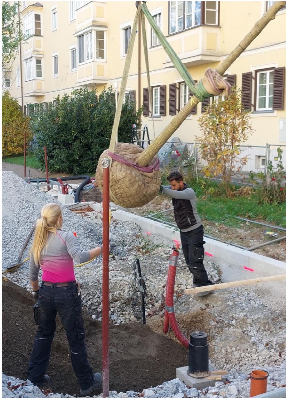
Versetzen erste Bäume auf Substratschichten
