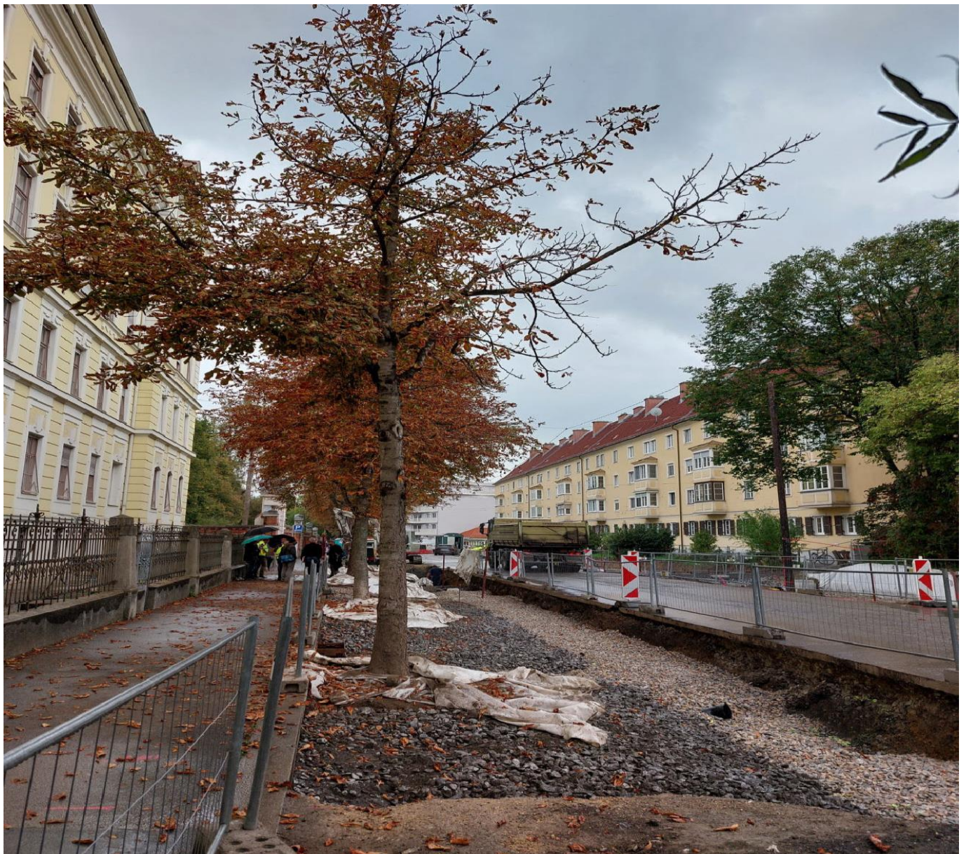
Versetzte Bäume in der Schwamm-System Fläche
