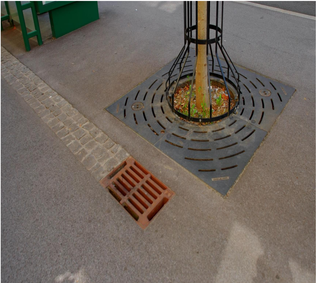
Regenwasser über Einlaufschacht zum Baum anstatt in den Kanal
