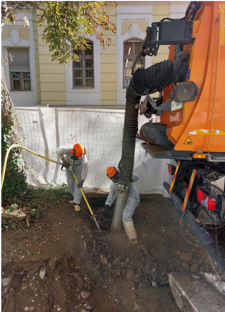
Auflockerung vom bestehendem Wurzelbereich an Bestandskastsanien
