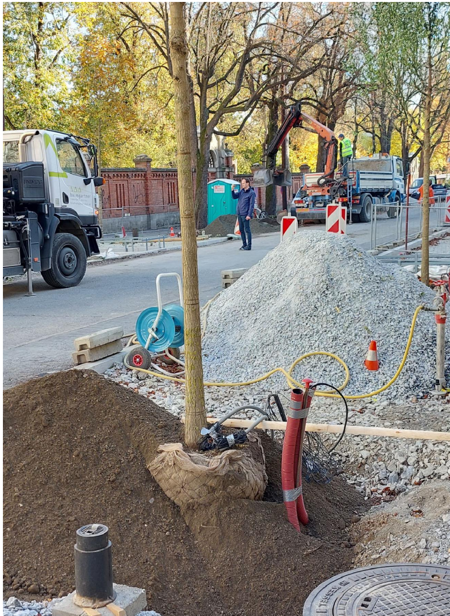
Baumsetzung neue Baumreihe in Substrat-Material am Leonhardgürtel
